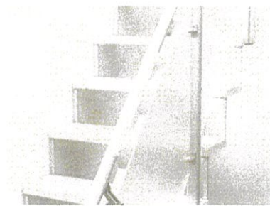
階段手摺へのテープ活用
